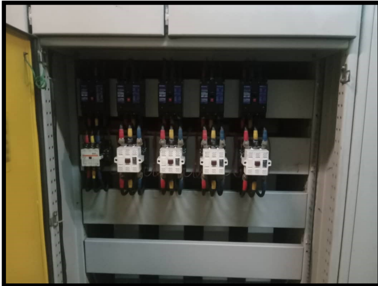
CAPACITOR BANK DI BLOK SP1
